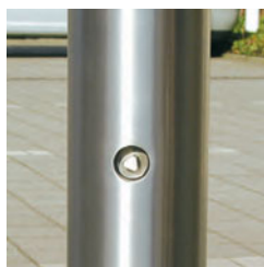
Dreikantschlüssel nach DIN 3223
