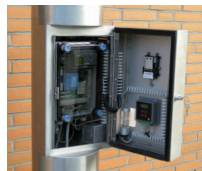
Einbaubeispiel: Wechselsprechanlage mit Ruftaster, berührungsloser Leser (RFID), Ampel (rechts unten)
