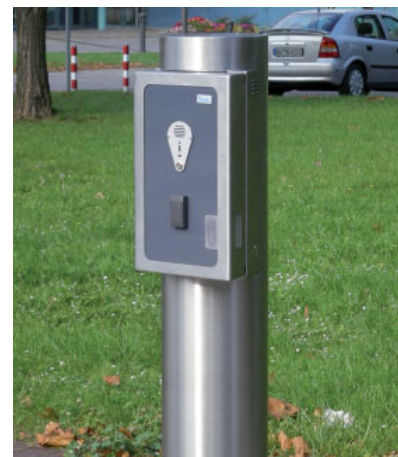
Einbaubeispiel: Wechselsprechanlage mit Ruftaster, berührungsloser Leser (RFID), Ampel (rechts unten)
